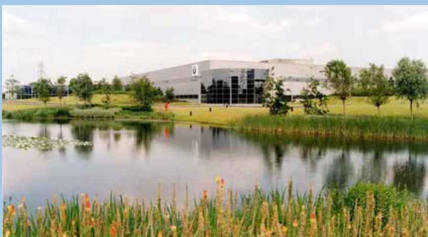
De waterberging wordt op Hams Hall, Birmingham (UK), gecombineerd met een parkachtige inrichting. Zo is een mooie overgang naar de omgeving ontstaan.
