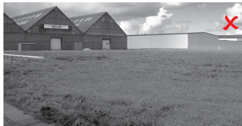
Groot deel van het perceel niet in gebruik
