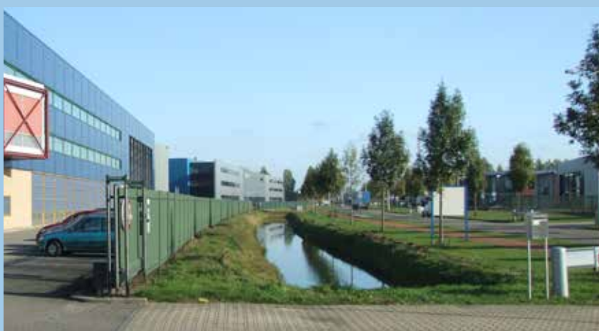
Deze afwateringssloot dient tevens om extra ruimte te scheppen in het wegprofiel.
